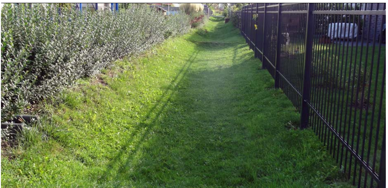
Gemeinsame Versickerungsmulde zwischen Grundstücken
